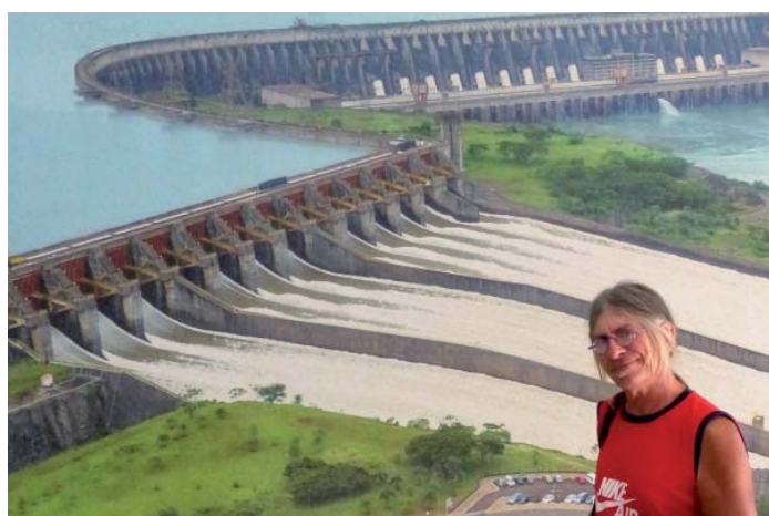
12 et 13 - vue d'ensemble du barrage d'Itaipu
