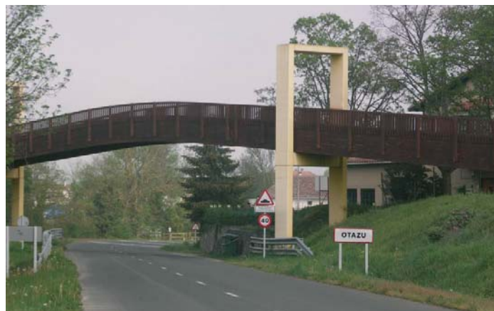
2 - la voie verte traverse sur une passerelle
