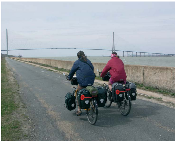
Le Pont de Normandie
